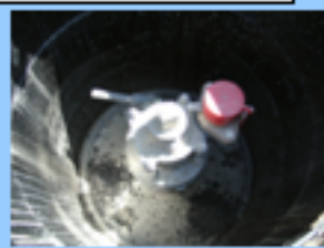
(蓋を開けると消火栓がある)
